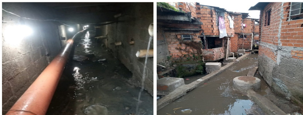
Figura 4 - Técnicas não convencionais adotadas no “Programa Novo Rio Pinheiros”. Fonte: SABESP (2023).
