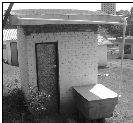
Figura 2 - Telhado verde (Protótipo A), com reservatório de armazenamento (Área A =11,8m 2 ).
