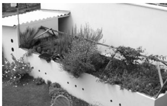
Figura 5 - Telhado verde (Protótipo B) ( \text{Área}_B = 9,4\text{m}^2 ).
