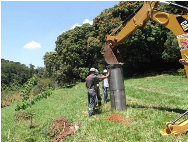
Figura 6 - Posicionamento do Cilindro do Lisímetro para Cravação no Solo.
