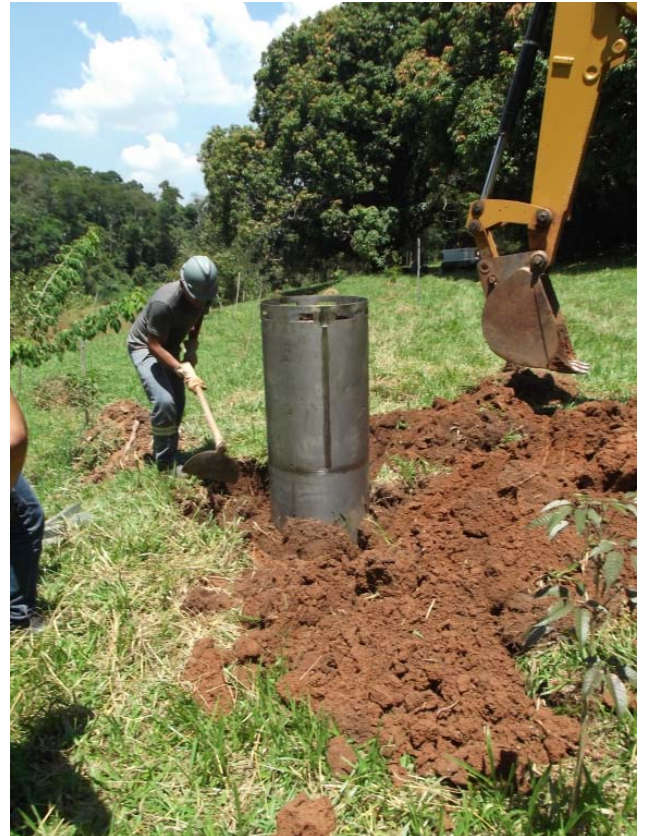
Figura 7 - Escavação em Torno do Monólito
