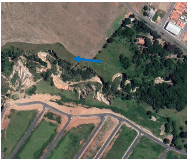
Figura 2 – Vista Geral da erosão hídrica do tipo boçoroca, seta azul indica o sentido do escoamento das águas pluviais. (Fonte Google Earth).
