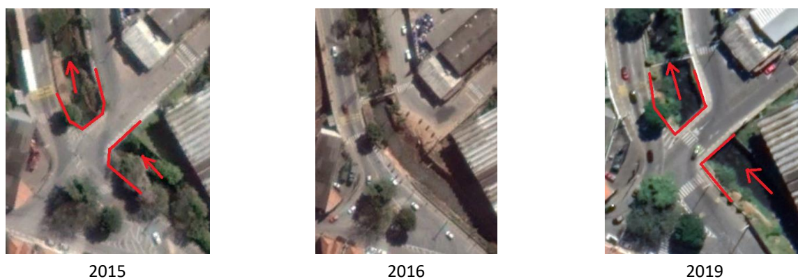
Figura 4 - Imagens de satélite da ponte Faculdade, com sentido do escoamento e ângulos de encontro em vermelho (fonte: adaptado de Google Earth)
