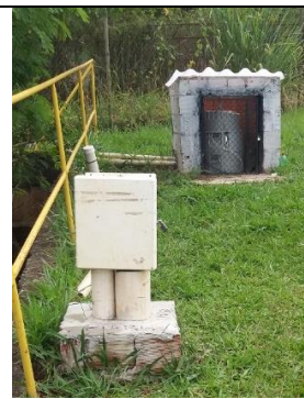
Figura 04 – Equipamentos rente à galeria de drenagem.
