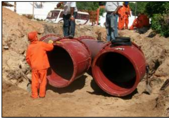
Figura 2 - Execução do Coletor Tronco.
