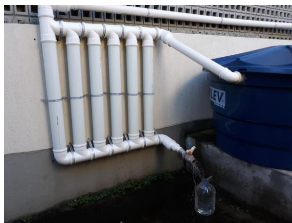
Figura 2: Dispositivo de descarte automático, DesviUFPE, utilizado.
