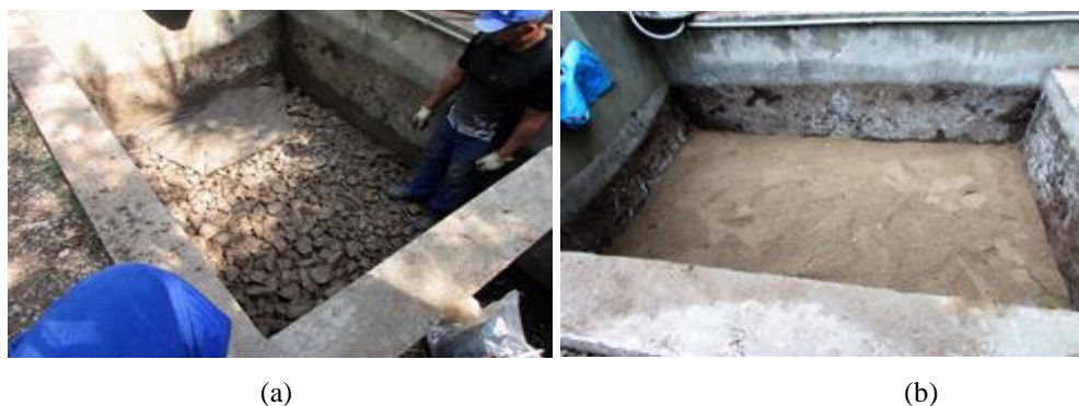
Figura 5 – (a) Retirada do substrato (b) material já substituído (areia). Foto: autores
