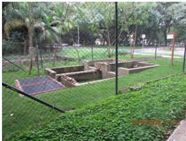
Figura 8 – Jardim de chuva já reformado. Foto: autores
