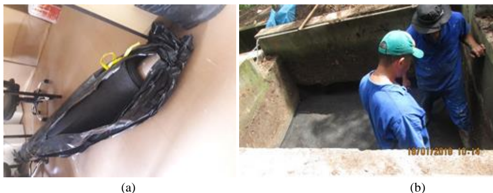
Figura 6 – (a) Geocomposto (b) aplicação do geocomposto no canteiro 1. Foto: autores
