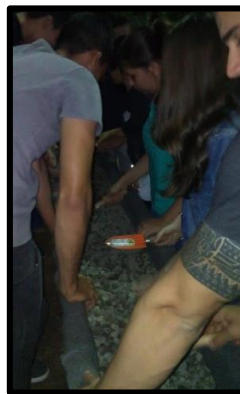
Figura 6: colocação de agregado Fonte: as autoras
