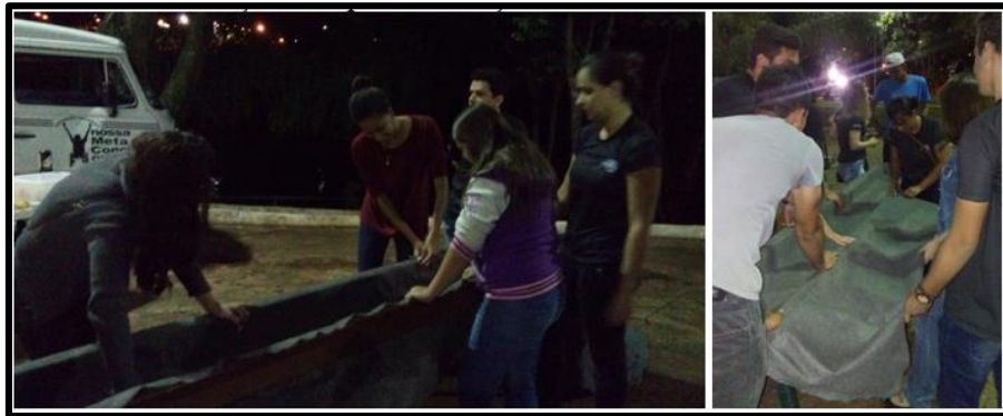
Figura 5: Demonstração impermeabilização. Fonte: as autoras
