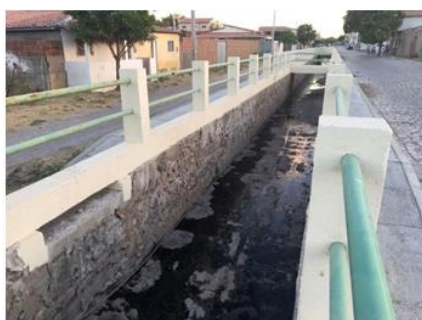
Figura 5 – Canal de Esgoto (Centro)
