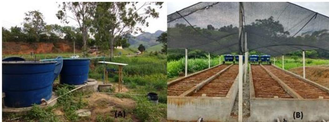
**Figura 1** – Unidade piloto de tratamento de água residuária, reservatórios de 5.000 L e filtro orgânico (A) e rampas de tratamento e reservatórios de 500 L (B).
