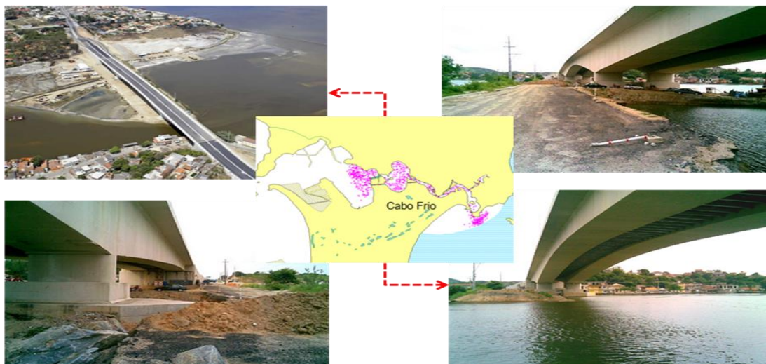
Figura 3.- Estrutura da ponte sobre o canal de Itajurú, Cabo Frio. (fonte: autoria própria)
