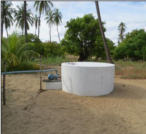
Figura 3 - Detalhe do poço amazonas da empresa de água potável, equipado com bomba centrífuga, mostrando parte da área irrigada através do rejeito do dissalinizador.
