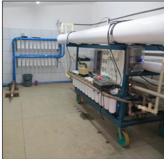
Figura 4 - Estação de tratamento da água com dissalinizador e ozonização.
