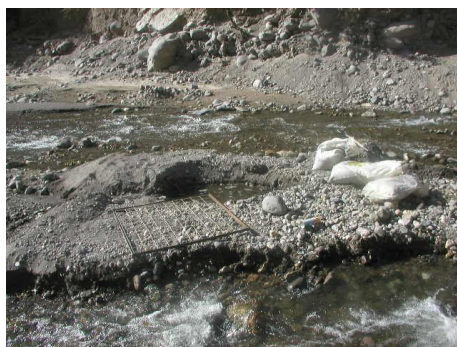
Figura 2 – Armadura en el lecho del río Torata.
