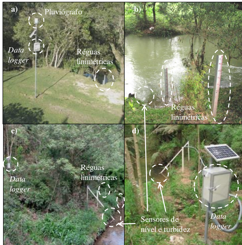
Figura 2 - Monitoramento hidrossedimentológico no exutório das três bacias: a) e b) bacia RB01, monitoramento de precipitação, turbidez e nível; c) bacias RB10 e d) RB11, monitoramento de nível e turbidez.
