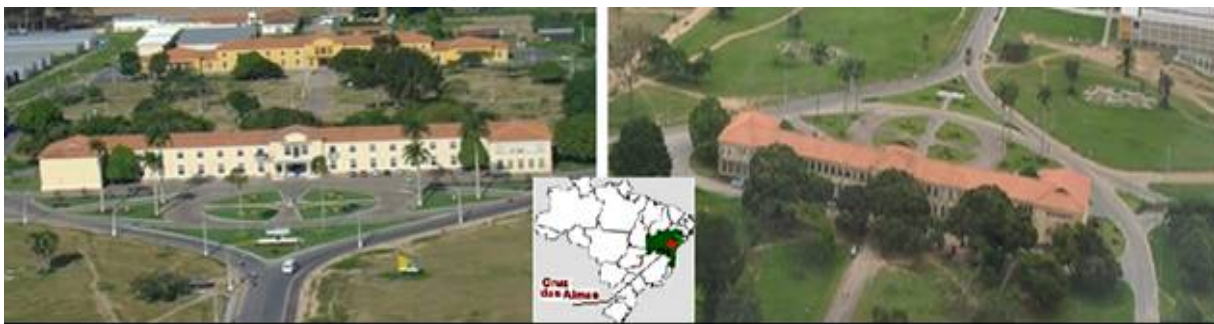
Figura 3 - Vista aérea frontal e de fundo do prédio da Reitoria da UFRB. (Fonte: ASCOM/UFRB, 2012)
