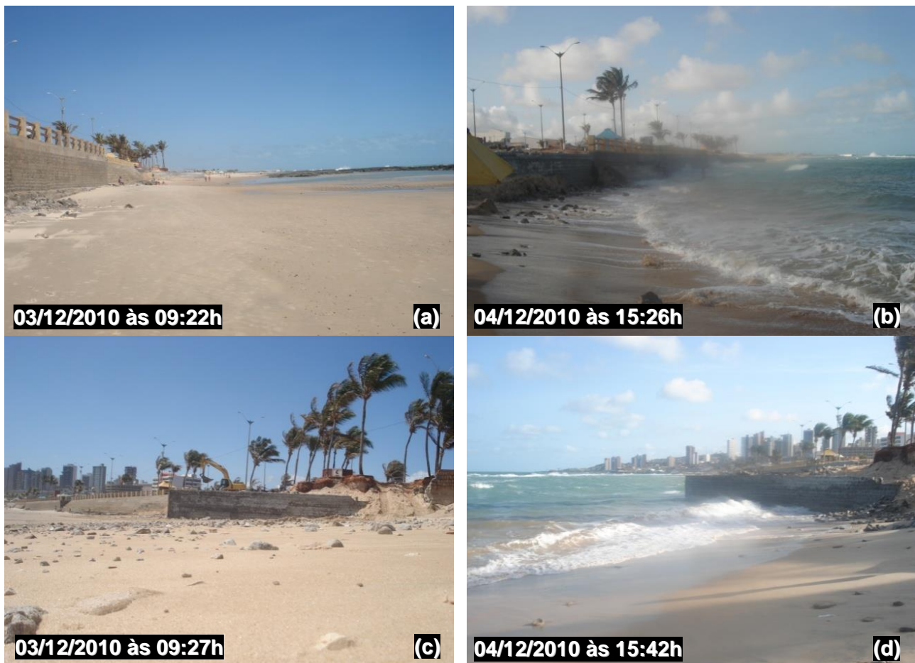
Figura 5: Praia do Meio, muro de arrimo, base do calçadão (a, c) maré baixa e (b, d) maré alta.
