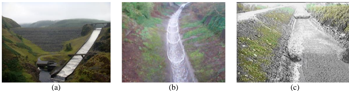
Figura 3 – Propagação de rollwaves em canais artificiais: (a) Rollwaves em vertedouro do reservatório de LlynBrianne, em Wales, Reino Unido, (b) Roll waves em um canal de concreto (Lions Bay, British Columbia – Canadá), (c) Filme do Cemagref - Grenoble - França.
