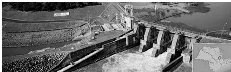
Figura 1 - Vista aérea da barragem do reservatório de Mogi-Guaçu e sua localização no Estado de São Paulo Fonte: AES Tietê (2018)
