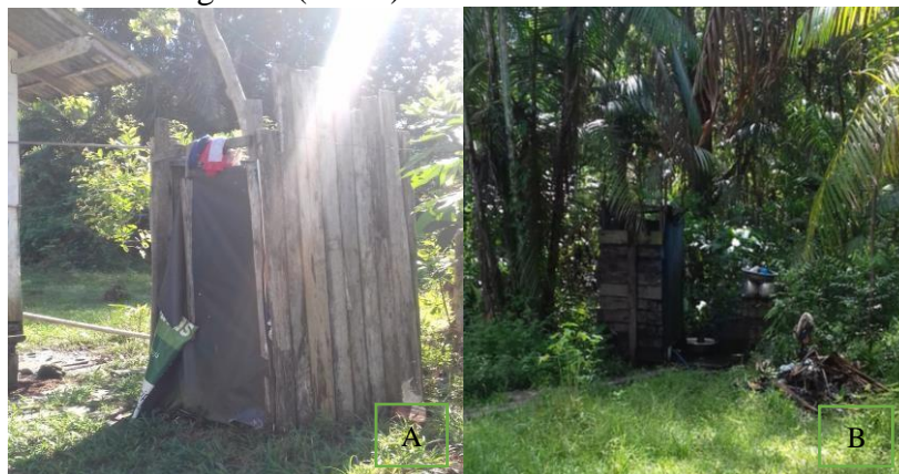
Figura 4 - banheiro a céu aberto utilizando a fossa negra
