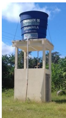
Figura 2 - Casa de bomba, poço e reservatório
