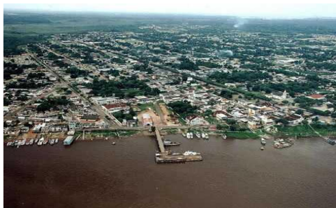
Figura 2 – Porto Central de Itacoatiara. Fonte: Google (2015).
