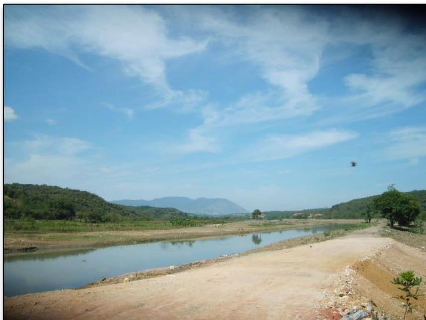
Figura 3– Vista do “dique” existente na foz do rio Botas, decorrente do acúmulo de material dragado.
