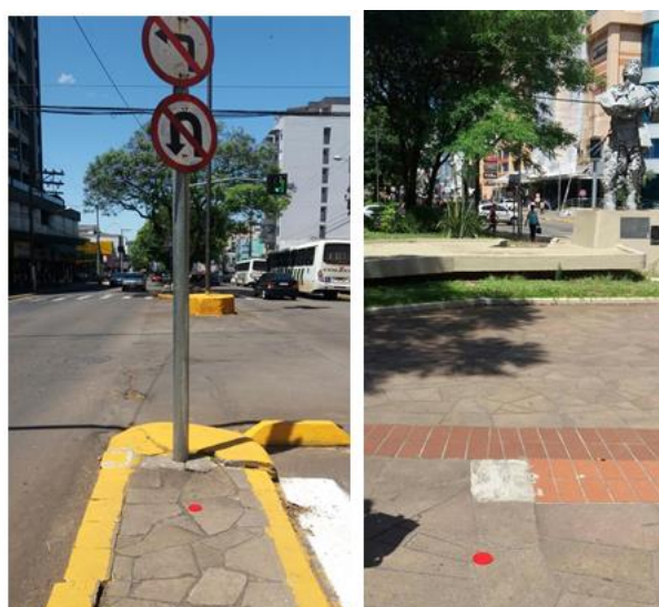
Figura 5 - Monitoramento de dados em pontos da Avenida Brasil.
