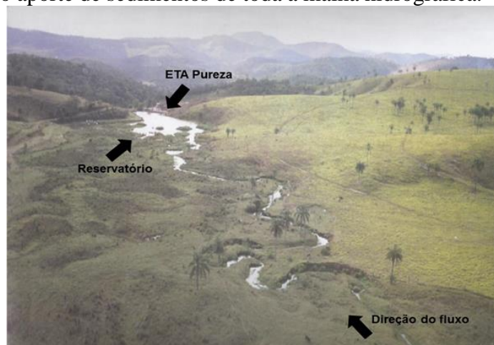
Figura 2 - Vista parcial do reservatório da barragem de controle de nível da ETA Pureza. Fonte: Adaptado de
