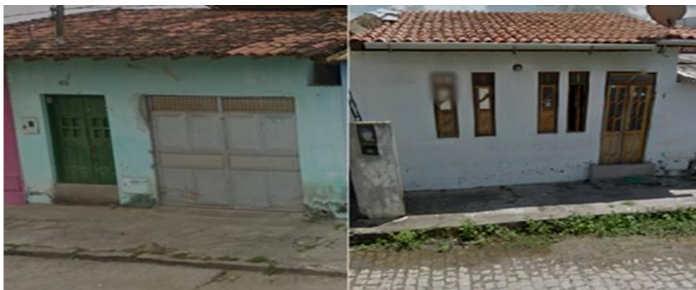
Figura 1 – Residências com muretas nas portas de entrada (Fonte: próprio autor)
