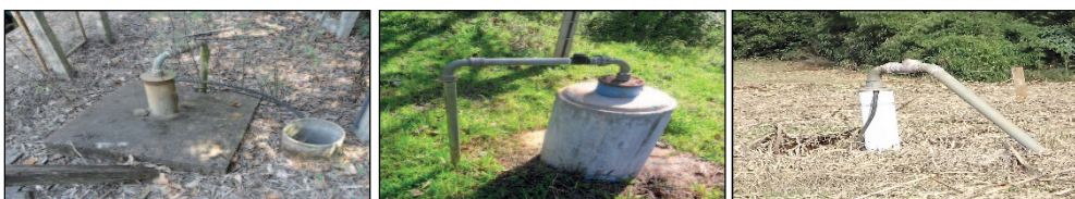
Figura 03: Pontos de coleta Nº 12, 14 e 21- poços com teores de manganês em desconformidade. Fonte: Acervo dos autores.
