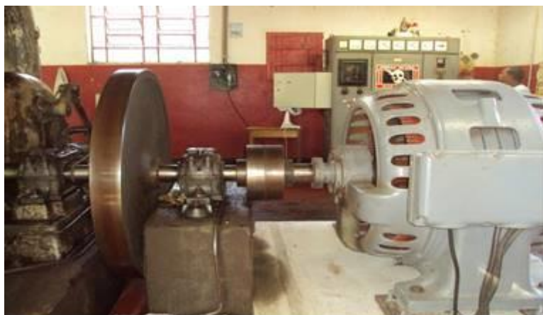
Figura 2. Turbina da PCH.
