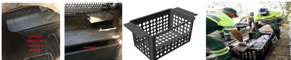
**Figura 3 - Cesto no interior de uma boca de lobo em Los Angeles, Califórnia. Fonte: Fotos dos autores. Cesto de retenção em São Paulo. Fonte: PMSP (s/d).**
