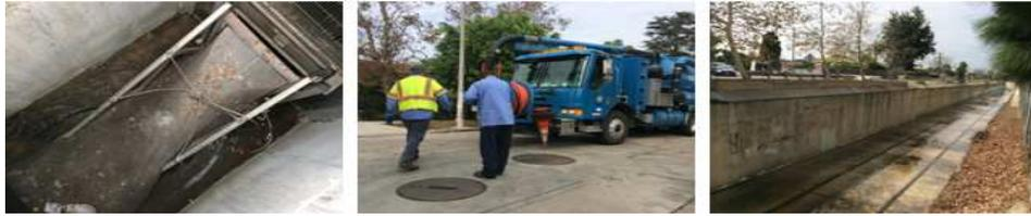
**Figura 4 - Redes de aço no interior de uma galeria afluyente de um córrego de Los Angeles.**
