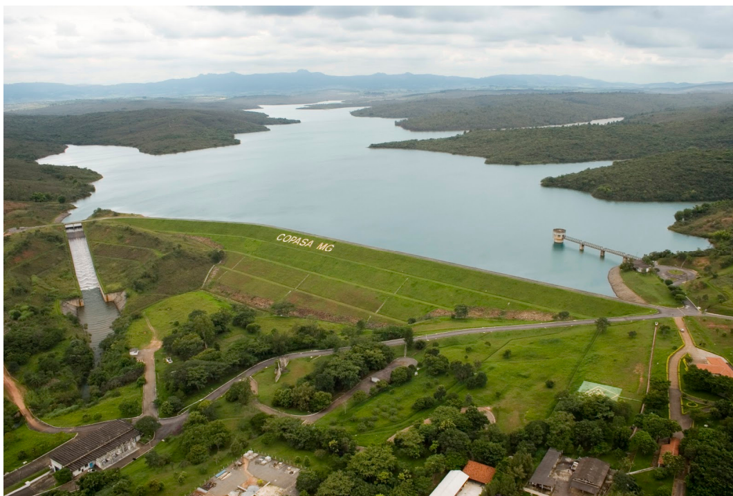
Figura 2 – Reservatório Serra Azul da COPASA
