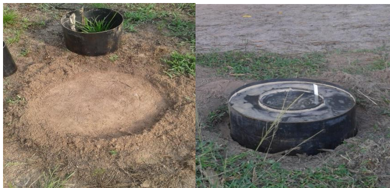
Figura 2 – Limpeza da área e subsequente instalação dos anéis concêntricos para realização do teste. Fonte: autores.
