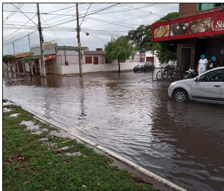
Figura 1 – Alagamento da Avenida Sideral
