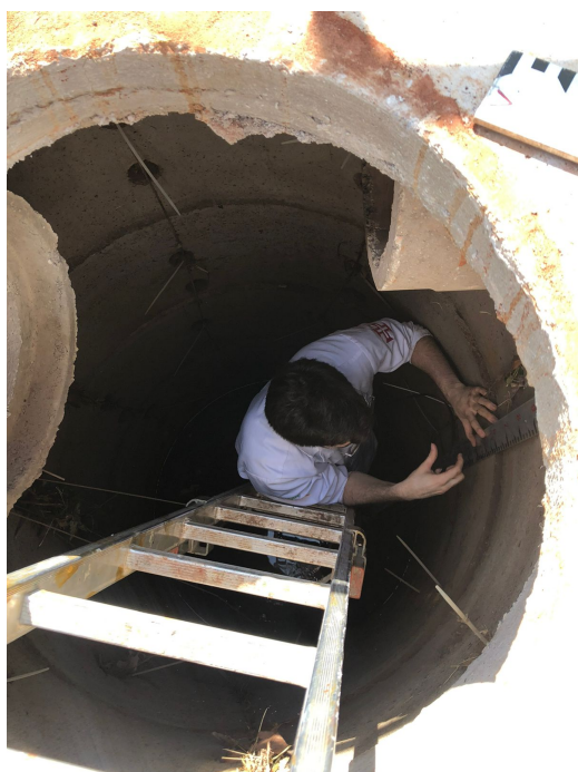
Figure 7: Poço de infiltração - detalhe da instalação da régua linimétrica.
