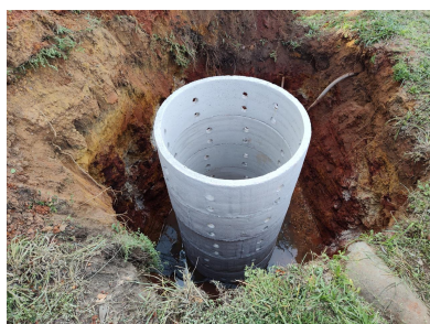
Figure 3: Poço de infiltração - detalhe do processo de construção com anéis de concreto.
