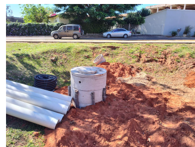
Figure 5: Poço de infiltração - configuração final antes de conexão com a rede.
