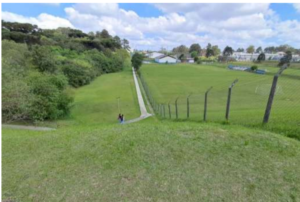
Figura 4 - Trecho de galeria subterrânea. Foto obtida do topo da encosta direita do vale
