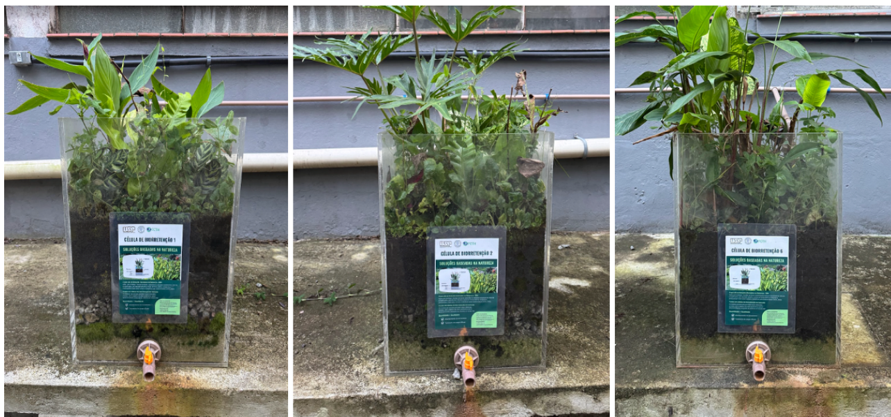
Figura 2 – Células de bioretenção no CTH-USP. Fonte: Autoral.
