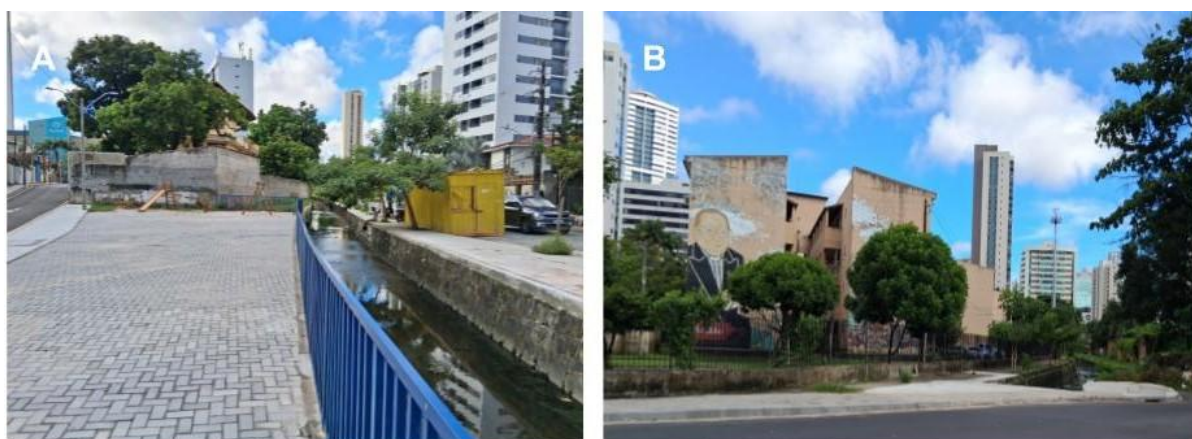
Figura 2 - (A) Margem do riacho requalificada onde antes estavam ocupações irregulares. (B) Conjunto habitacional construído para realocação das famílias (Fonte: Autores)
