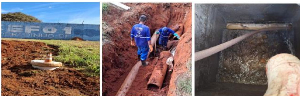
Figura 4 – Execução de medidas corretivas na rede (CAESB, 2025).
