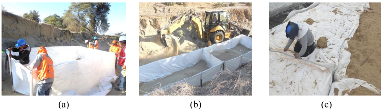
Figura 4 – (a) Montagem, (b) preenchimento e (c) fechamento das bolsas.
