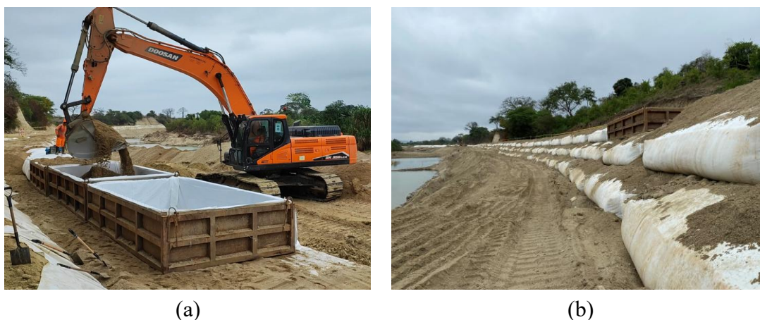
Figura 11 – Rio Zarumilla, Peru. (a) Uso de fôrma e escavadeira para preenchimento. (b) Parte de vários quilômetros de margem com bolsas de geotêxtil.
