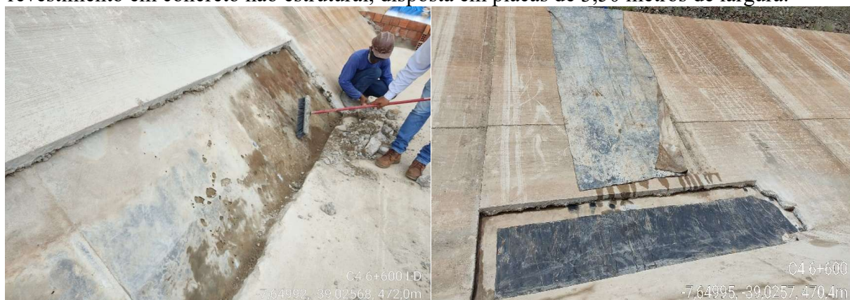
Figura 6 – Manutenção corretiva: (a) demolição do concreto; (b) reparo da geomembrana de PVC.
