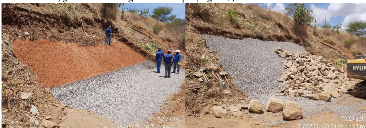
Figura 5 – Execução do rockfill : (a) aplicação de areia e brita; (b) aplicação de rochas.
