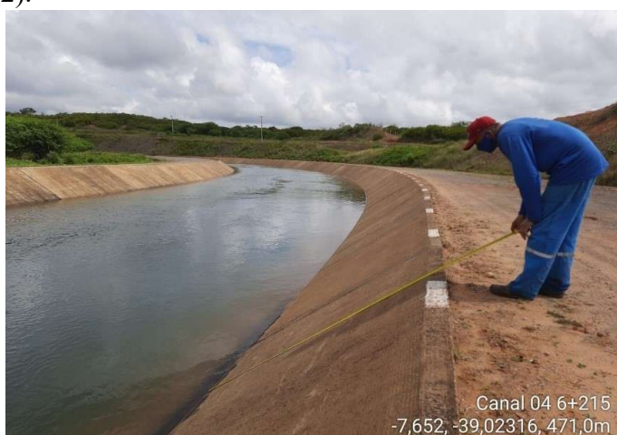
Figura 2 – Medição do talude (borda livre) para cálculo de N.A do canal.
