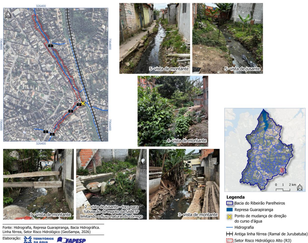
Figura 2 – Limites do setor de risco e registro fotográfico. Fonte: Elaborado pelas autoras.
