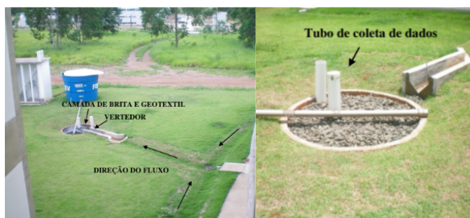
Figura 5 – Poço de infiltração associado a canal gramado – detalhes de funcionamento. Fonte: Angelini Sobrinha, 2012.
