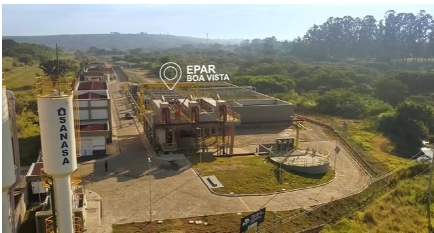
Figura 2 - Estação Produtora de Água de Reuso “Boa Vista” Fonte: SANASA/Campinas, 2021.
