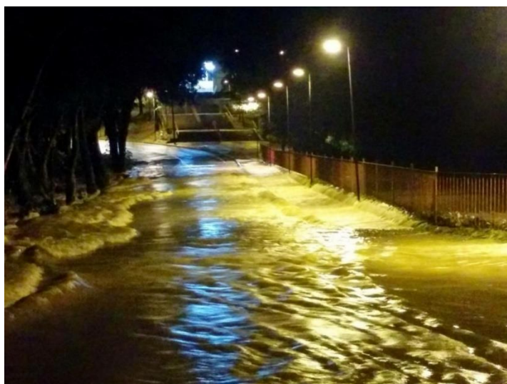
Figura 1 – Galgamento da barragem no evento de 28 de dezembro de 2022. Fonte: acervo PU-UFSCAR.
