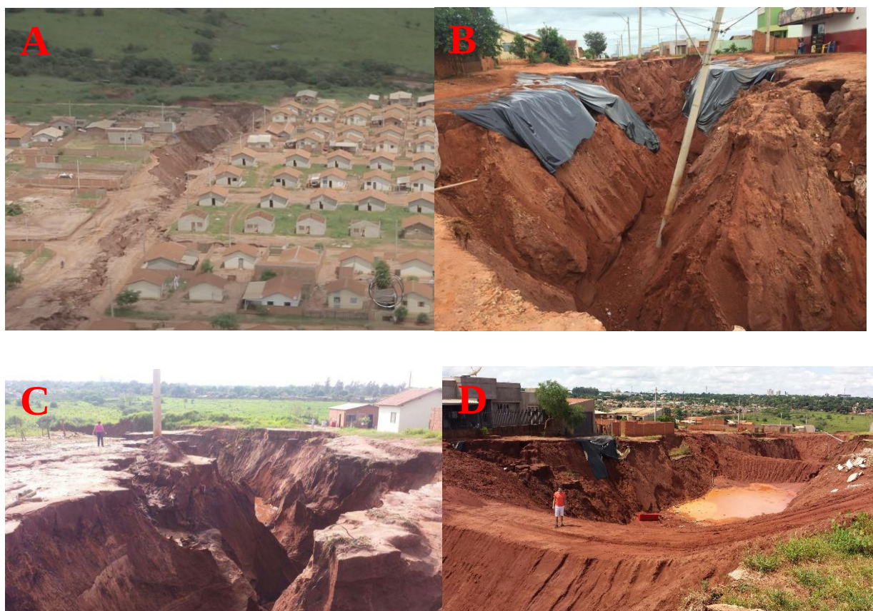
Figura 3 Imagens das voçorocas no Bairro Jardim Paraíso IV e Vila Alta: a) imagem aérea mostrando a cabeceira, taludes laterais e a base b) indicação do comprometimento da rede elétrica devido à expansão das voçorocas c) erosão profunda e progressiva no Latossolo Vermelho distrófico d) criação das bacias de retenção e barragens para conter a progressão da erosão.
