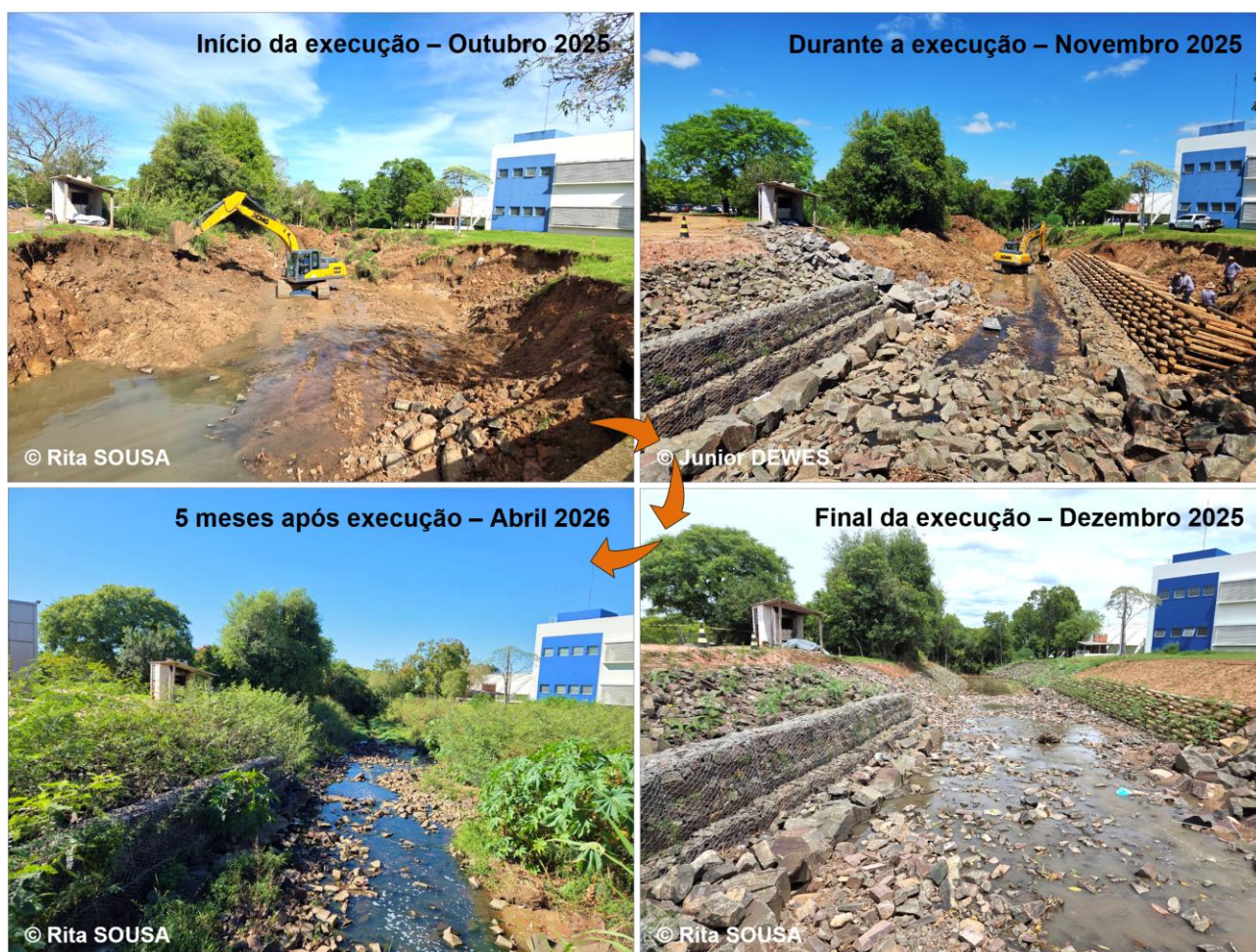
Figura 3 – Evolução da área de intervenção (vista de montante para jusante) entre Outubro de 2025 (início da obra) e fim de Abril de 2026 (5 meses após a intervenção).
