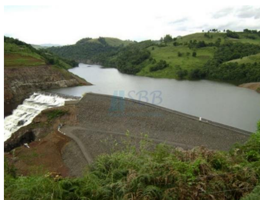
Figura 4 - Barragem do Alto Irani.
