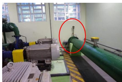
Figura 2 – Dataloggers instalados (a) na tubulações de recalque da EBAT Oscar Pereira/RES Primeiro de Maio; (b) e exemplo de datalogger instalado em estação pitométrica. Fonte: Rocha, 2021.
