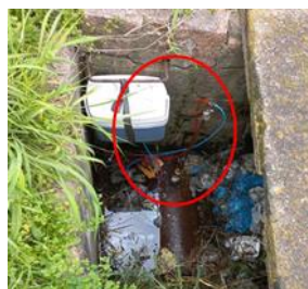
Figura 2 – Dataloggers instalados (a) na tubulações de recalque da EBAT Oscar Pereira/RES Primeiro de Maio; (b) e exemplo de datalogger instalado em estação pitométrica. Fonte: Rocha, 2021.
