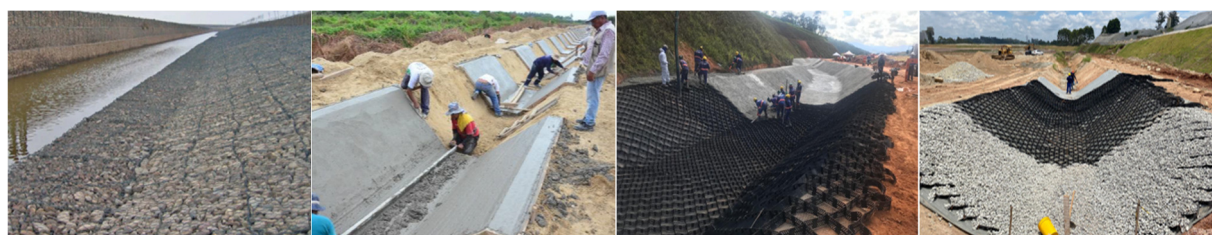
Figura 1 – Sistemas de revestimento avaliados: (a) gabião, (b) concreto armado, (c) geocélula com material granular e (d) geocélula preenchida com concreto.
