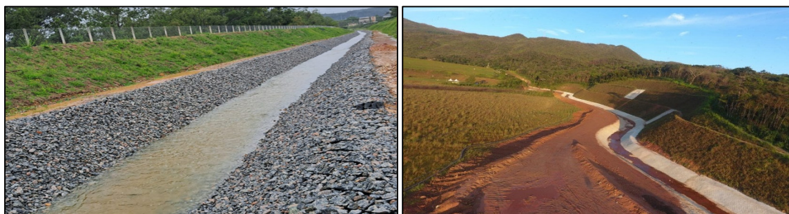
Figura 5 – Exemplos de projetos onde foram aplicadas as geocélulas com brita e concreto, respectivamente.
