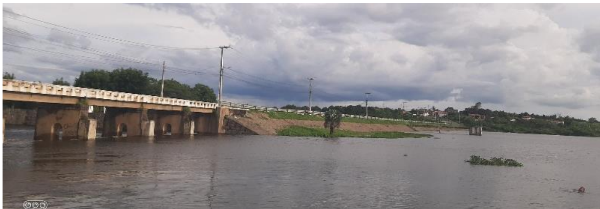
Figura 3 - O reservatório, a ponte de concreto armado sobre o sangradouro, a tomada d'água, a barragem do Açude Acaraú Mirim no ano de 2023. Fonte: Arquivo pessoal, 2023.
