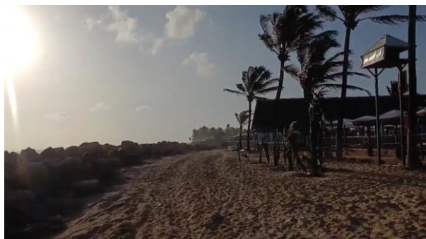
Figura 7 - Grande quantidade de pedras que foram colocadas em mais de 200 m de comprimento na praia para proteger as barracas na Praia da Tabuba. Fonte: Própria, 2025.
